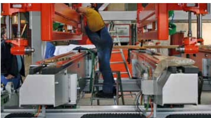
Die Anlage für die Herstellung von Großkisten ist derzeit bei Holmag im fertigwerden
